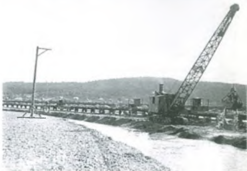
Тельбесское направление. Экскаватор на пневмоходу за работой по подготовке железнодорожного полотна
