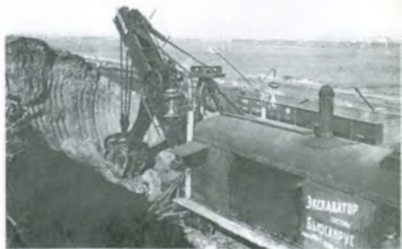
Тельбесское направление. Экскаватор на железнодорожном ходу «Бьюсайрус» (модель № 68-С) за срывом земляной насыпи
