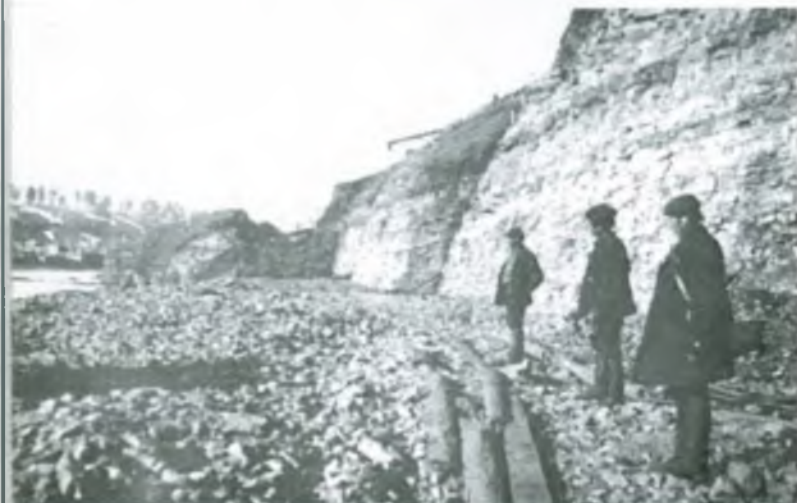
После взрывных работ
