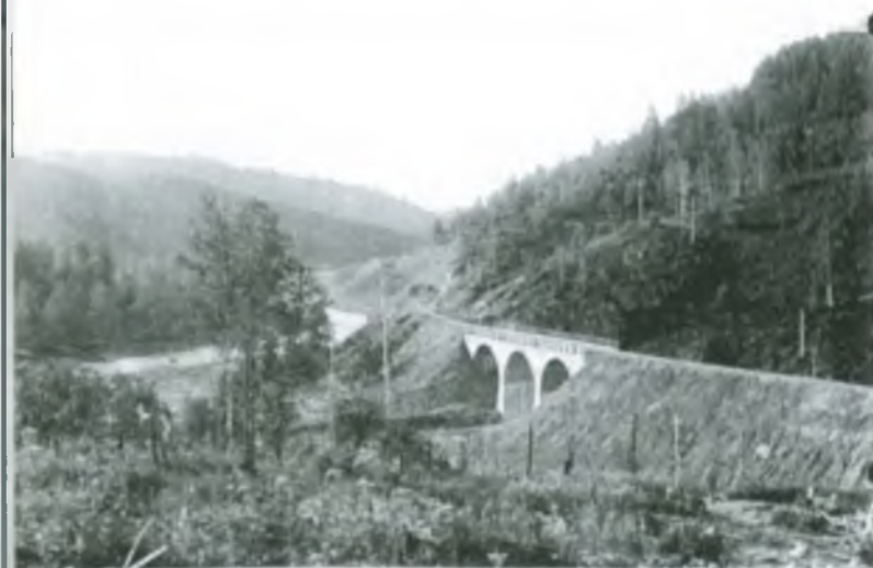
Участок Тельбесской ж/д возле излучины реки с уже построенным мостом и железнодорожной веткой
