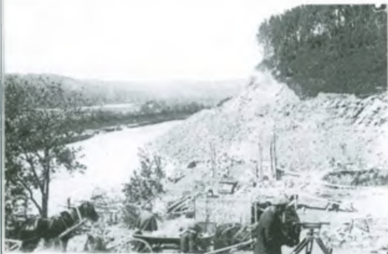
Участок Тельбесской ж/д возле излучины реки. Инженерное обследование
